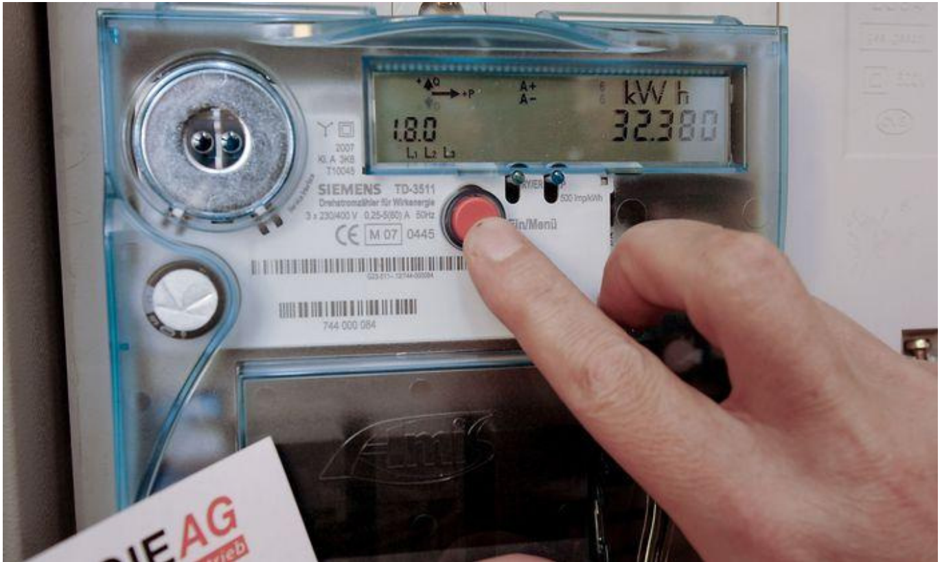
Intelligente Stromzähler Siemens AG
